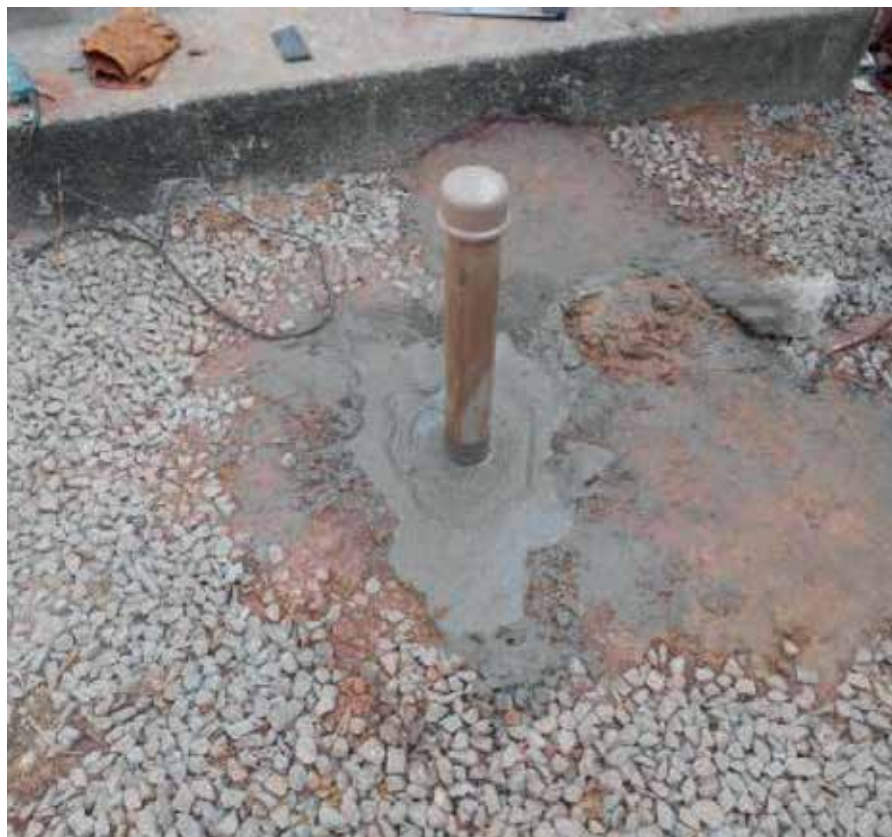
Figura 4 – Detalhe do furo para a realização do ensaio PS
