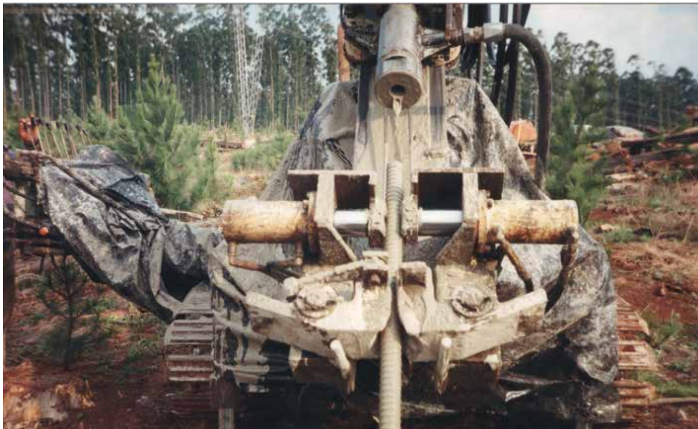
Perfuração de microestaca injetada à tração inclinada para linha de transmissão
