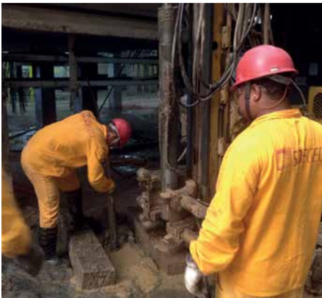
Execução em ambiente confinado
