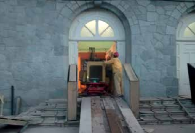
Fabricação da calda de injeção
